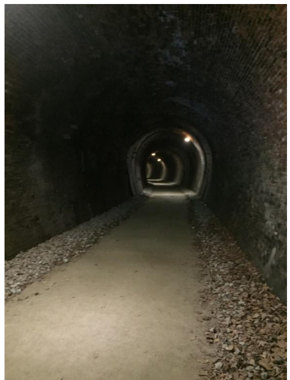
↑ 6号隧道内部(筆者撮影)
